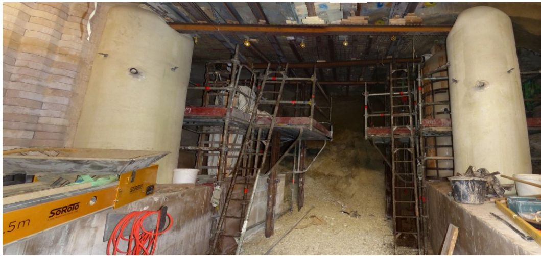
Abbildung 5: Aufwältigung im Abbau 3/658 (Überfahung, Maßnahme 1).
