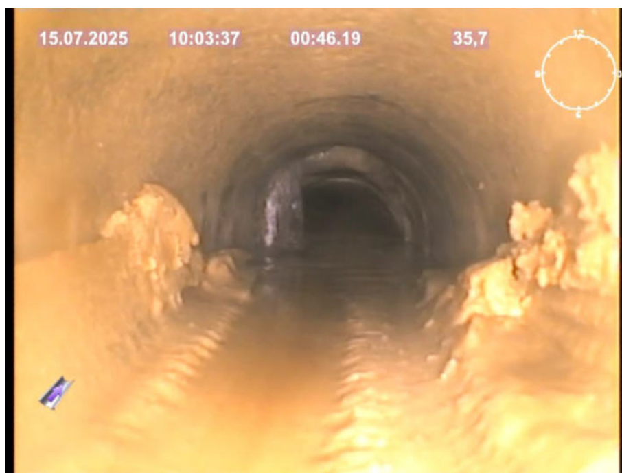
Abbildung 4: Lösung in der Erkundungsbohrung in die Südwestecke des Abbaus 3/658.
