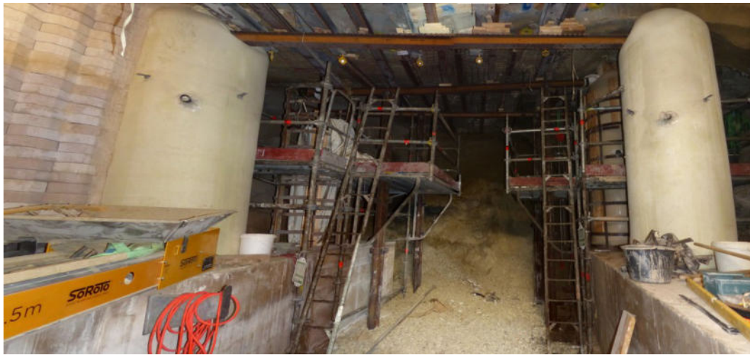
Abbildung 5: Aufwältigung im Abbau 3/658 (Überführung, Maßnahme 1).
