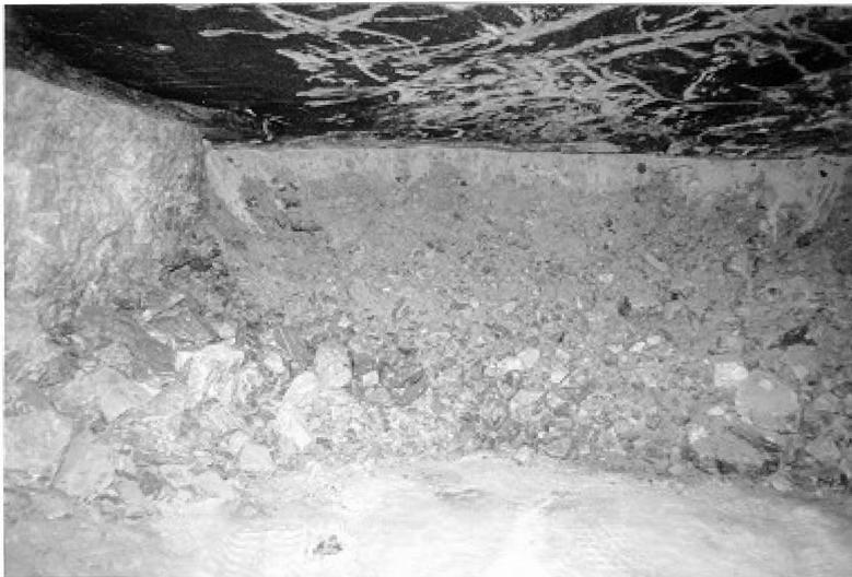
Abb. 5.32: Nach dem Gebirgsschlag vorgefundene mit Bruchmassen verfüllte Abbaukammern auf der 2. Sohle im Carnallitit
