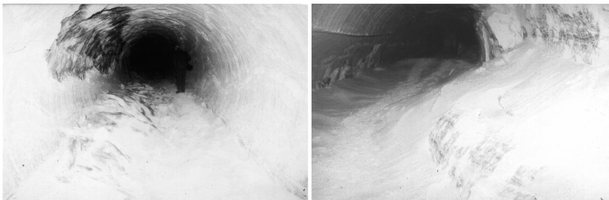
Abb. 5.5 Konturbrucherscheinungen und abgelagerter Salzstaub in der Maschinenstrecke 3 a Sohle.
