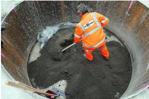
Abbildung 37: Verteilen des eingeschütteten Materials einer Einbaulage
