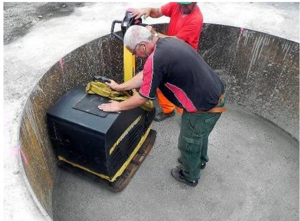
Abbildung 40: Einsatz der schweren Vibrationsplatte RP3 bei der schweren Vorverdichtung
