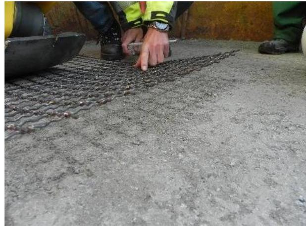
Abbildung 77: Aufrauungsversuch mittels Stahlbürste
