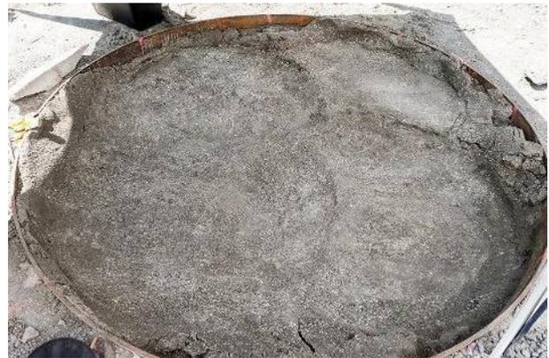
Abbildung 49: Oberfläche der impulsverdichteten 3. Schicht
