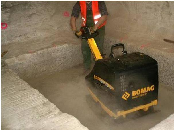
Abbildung 20: Staubentwicklung bei der Verdichtung mit der schwersten Rüttelplatte RP3 (M1L1)
