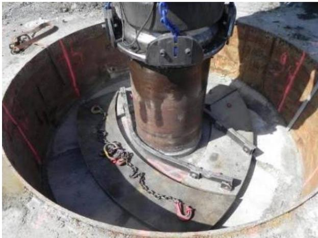
Abbildung 71: Beschwerungsplatten am Impulsverdichter
