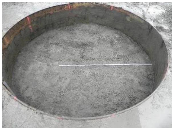
Abbildung 74: Gesenk nach der Entfernung des geschädigten Bereichs
