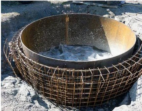
Abbildung 31: Fertig eingebaute Bewehrung für die Ringraumbetonage des Stahlringes
