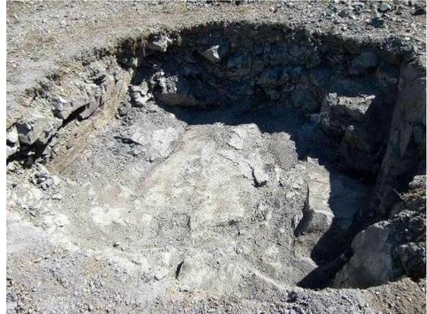
Abbildung 30: Durch schonendes Sprengen aufgefahrener Gesenk
