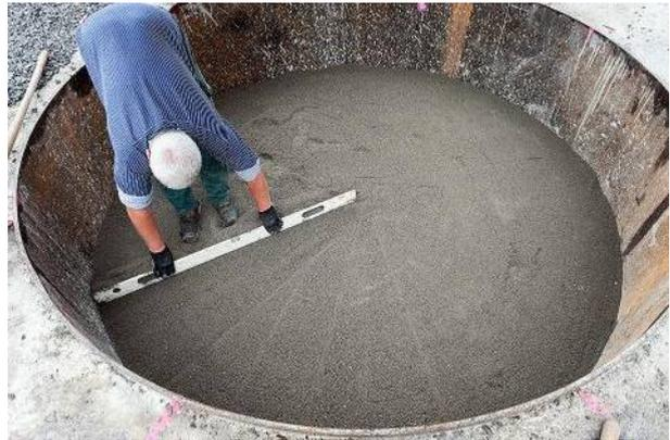
Abbildung 38: Abziehen des Materials einer Einbaulage mit einem Richtscheit
