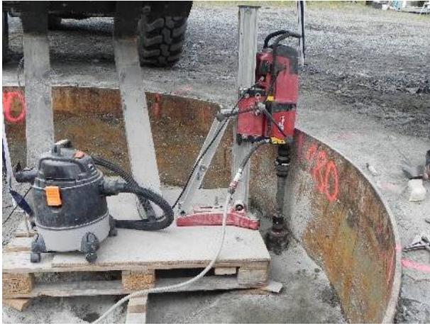
Abbildung 80. Kernbohrungen zur Probennahme
