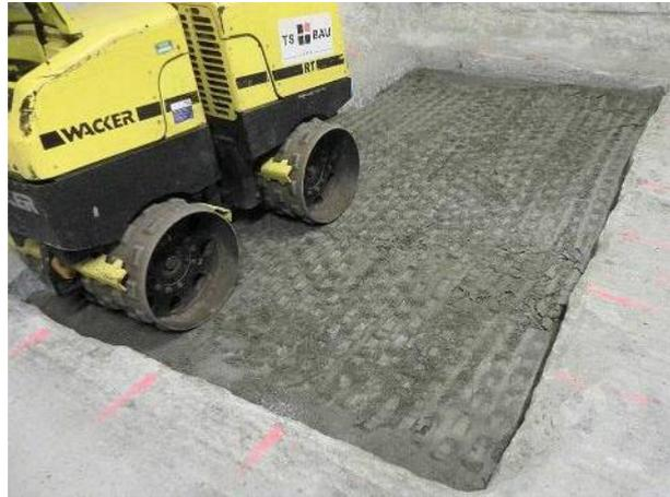
Abbildung 21: Oberflächenstruktur nach der Verdichtung mit der Grabenwalze (M2L6)
