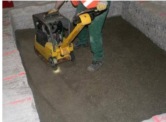
Abbildung 17: Vorverdichtung einer Lage mit der leichten Rüttelplatte RP1 (M1L1)
