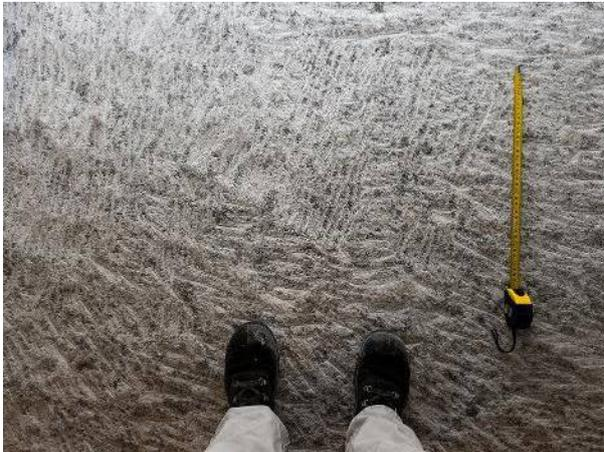
Abbildung 12: Oberflächenstruktur der Muldensohle
