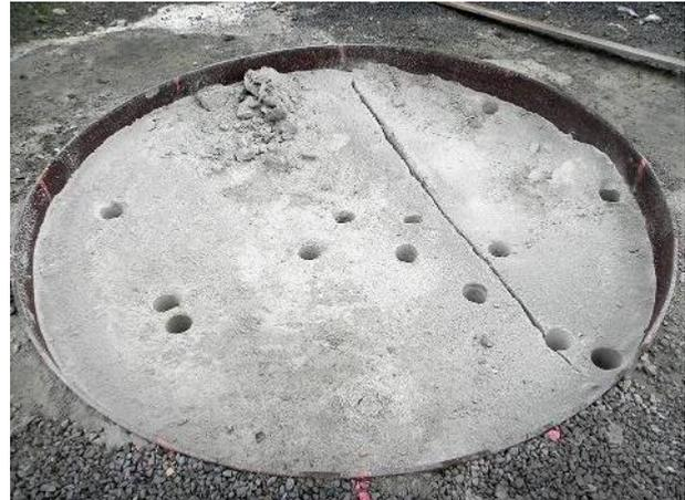
Abbildung 57: Ausführung des Sägeschlitzes
