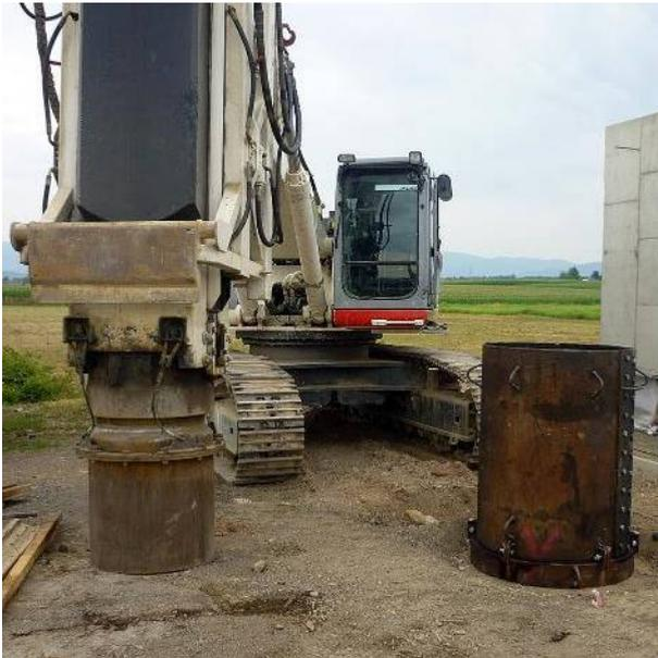
Abbildung 23: Im Vorversuch verwendeter Stahlbehälter mit dem Impulsverdichter
