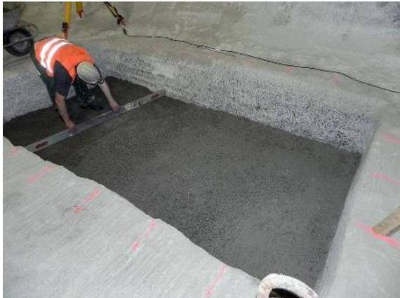
Abbildung 16: Abziehen der Lagenoberfläche nach dem händischen Einbau (M1L1)
