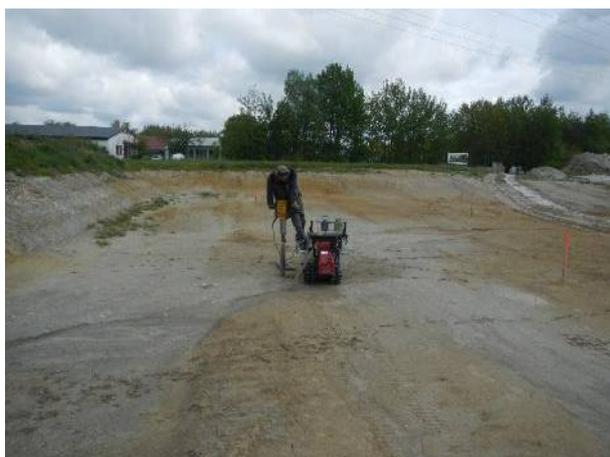
Abbildung 6: Erkundung mittels Rammkernbohrung
