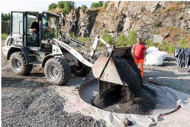
Abbildung 48: Überschüttung der 3. Schicht mit Splitt vor der Impulsverdichtung
