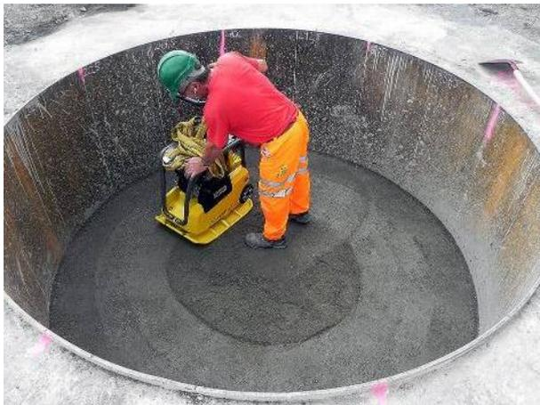
Abbildung 39: Einsatz der leichten Vibrationsplatte RP1 bei der leichten Vorverdichtung
