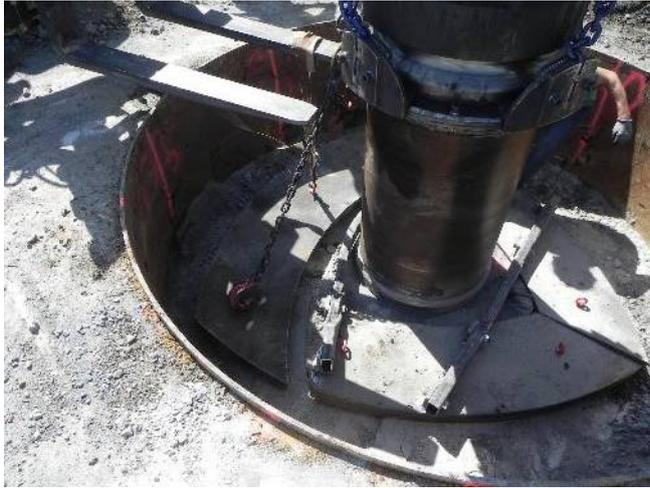
Abbildung 94: Beschwerungsplatten zur Reduktion der oberflächigen Auflockerungen während der Impulsverdichtung
