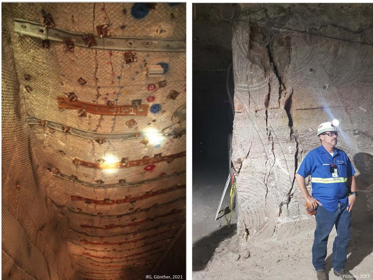
*Bild 6.32: WIPP Site – In-situ-Beispiele. Links: Rissbildung in Firste, infolge Horizontalkonvergenzen hervorgerufene Durchbiegung der Firste, rechts: ringförmige Abplatzung am Stoß.*
