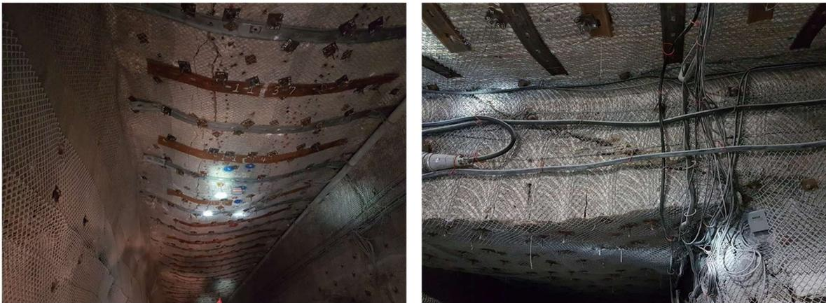
Abb. 29 Zugrisse in und über der Firste von untertägigen Strecken in der Waste Isolation Pilot Plant (Hampel, März 2018).
