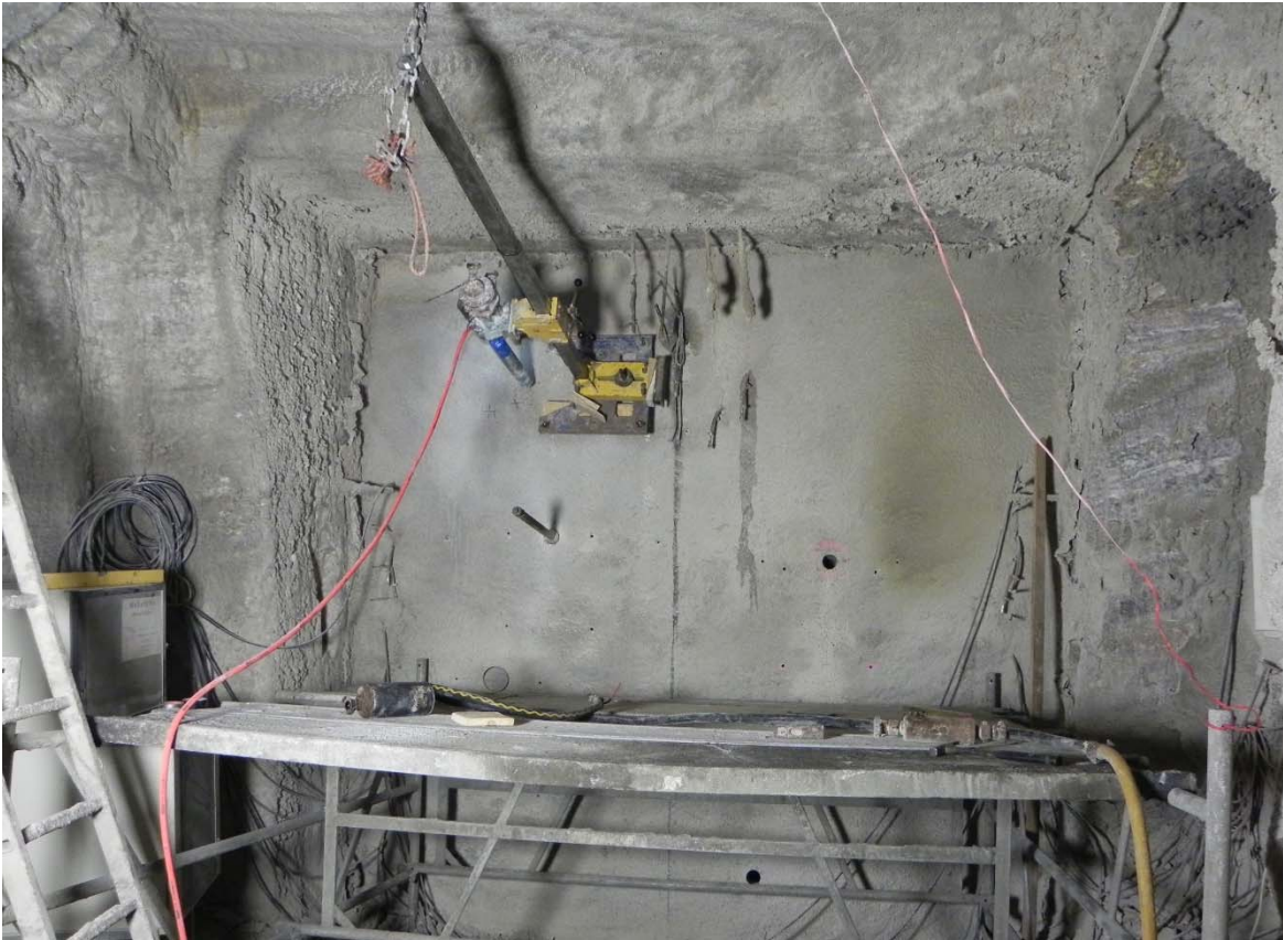
Abbildung A-1: Herstellen der Bohrung B40
