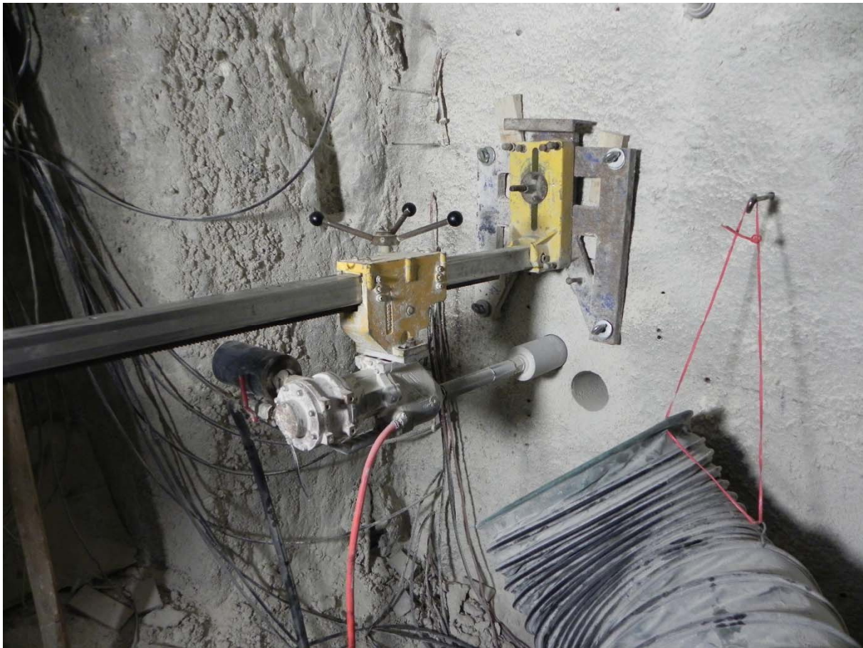
Abbildung A-6: Herstellen der Bohrung B42
