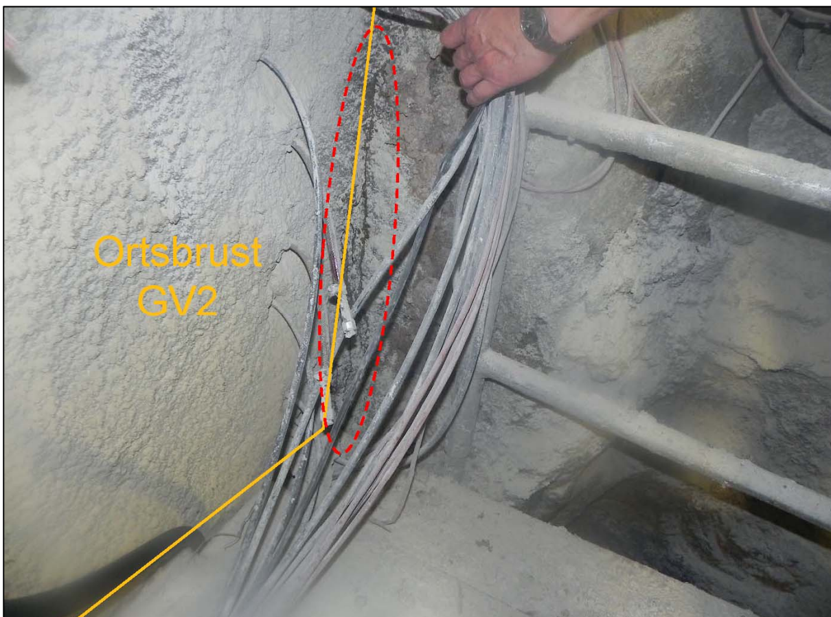
Abbildung 114: Lösungsaustritt am rechten Rand des GV2 (Aufnahmedatum: 15.05.2019)
