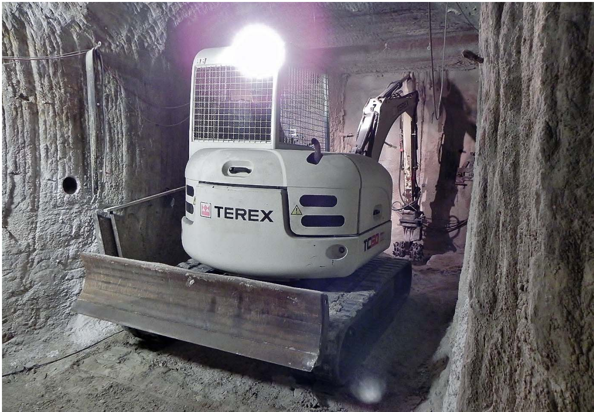
Abbildung A-8: Auffahren der Auffangrinne an der luftseitigen Ortsbrust am GV 2 (Mai 2016)
