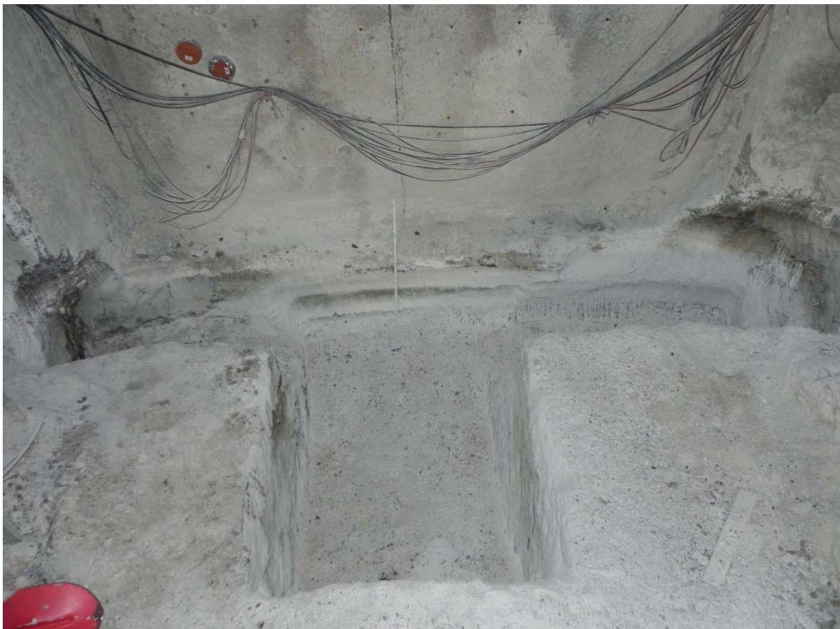
Abbildung A-9: Auffahren der Auffangrinne an der Ortsbrust am GV 2 (Mai 2016)
