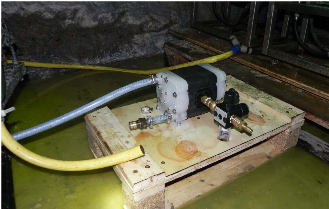
Abbildung A-13: Doppelmembranpumpe zum Einfüllen der Lösung in die Druckkammer
