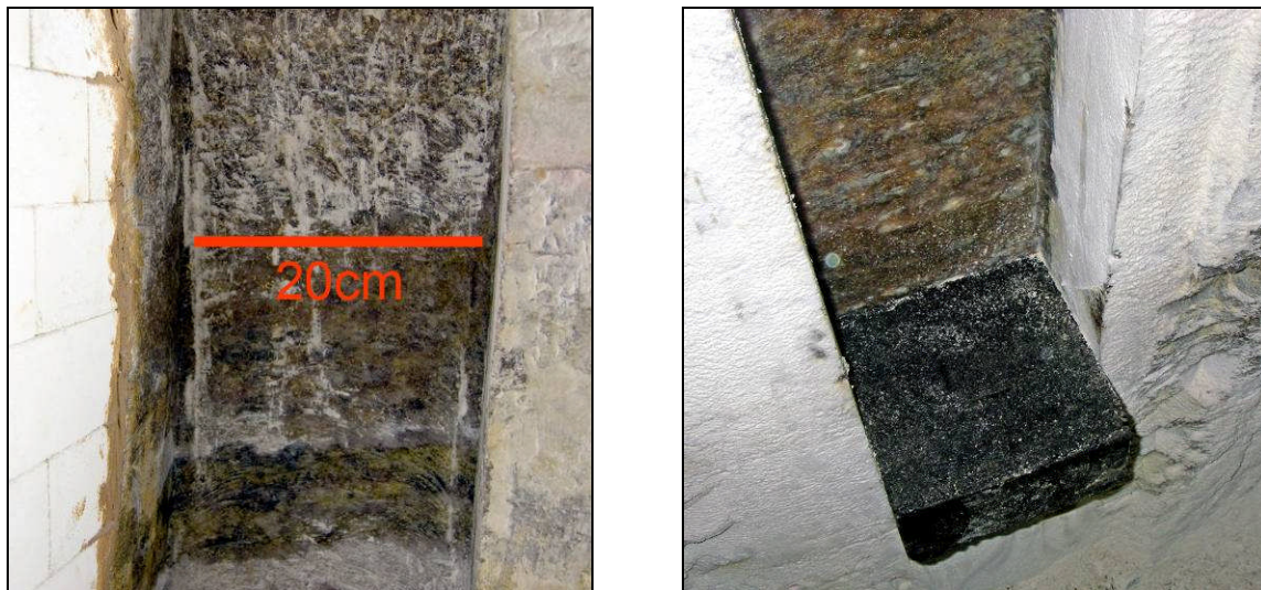
Abbildung 39: Fertiggestellter Gebirgsschlitz (links) und in den Gebirgsschlitz eingelegter Asphalt-Baustein (rechts)
