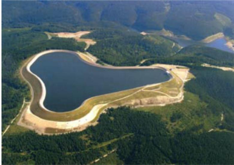
Abbildung 2-7 Pumpspeicher-Wasser-Kraftwerk Goldisthal, Realisierungszeitraum 30 Jahre: Speichervolumen 12 Mio. m<sup>3</sup>, Gesamtleistung 4 x 265 MW = 1060 MW, Arbeitsvermögen 8480 MWh, Entladezeitraum 8,3 h, Anfahrzeit 98 s
