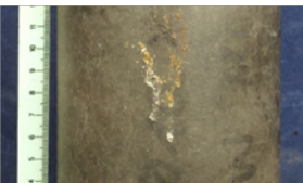
punktueller Austritt von Lösung
