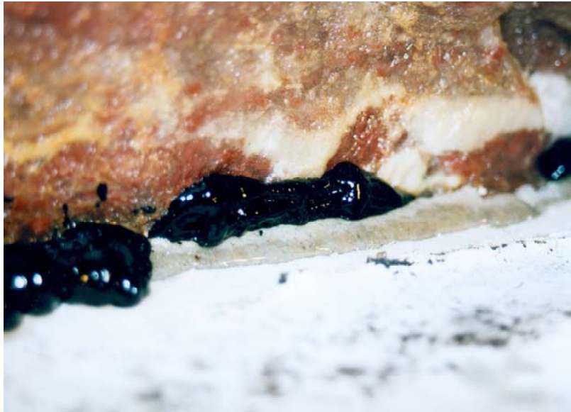
Abb. 53: Austrittsstelle des Injektionsbitumens mit ausgepresster Salzlösung
