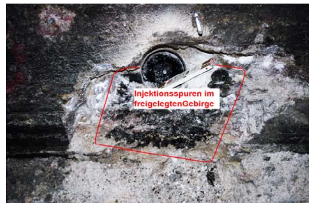
Abb. 48: Darstellung der mit Bitumen B900 injizierten Bereiche (13 cm hinter der Kontur, Draufsicht)
